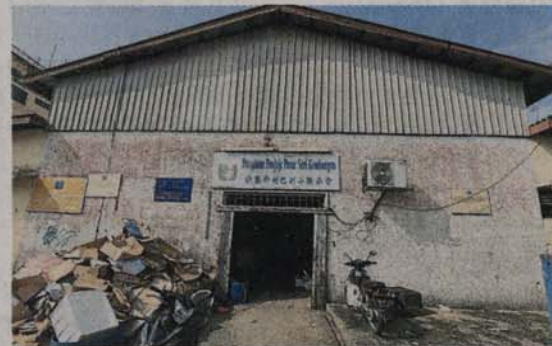
■ 沙登新村巴刹将在原址拆除重建, 计划兴建一座单层楼的新巴刹。
